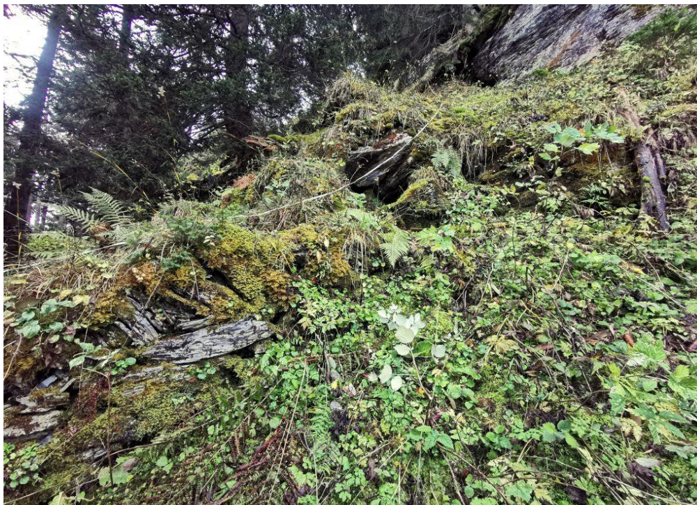
Abbildung 6: Schadstelle im Steilgelände am oberen Ende der Grenzmauer direkt unter dem Sässhopf auf ca. 1'676 m Höhe
