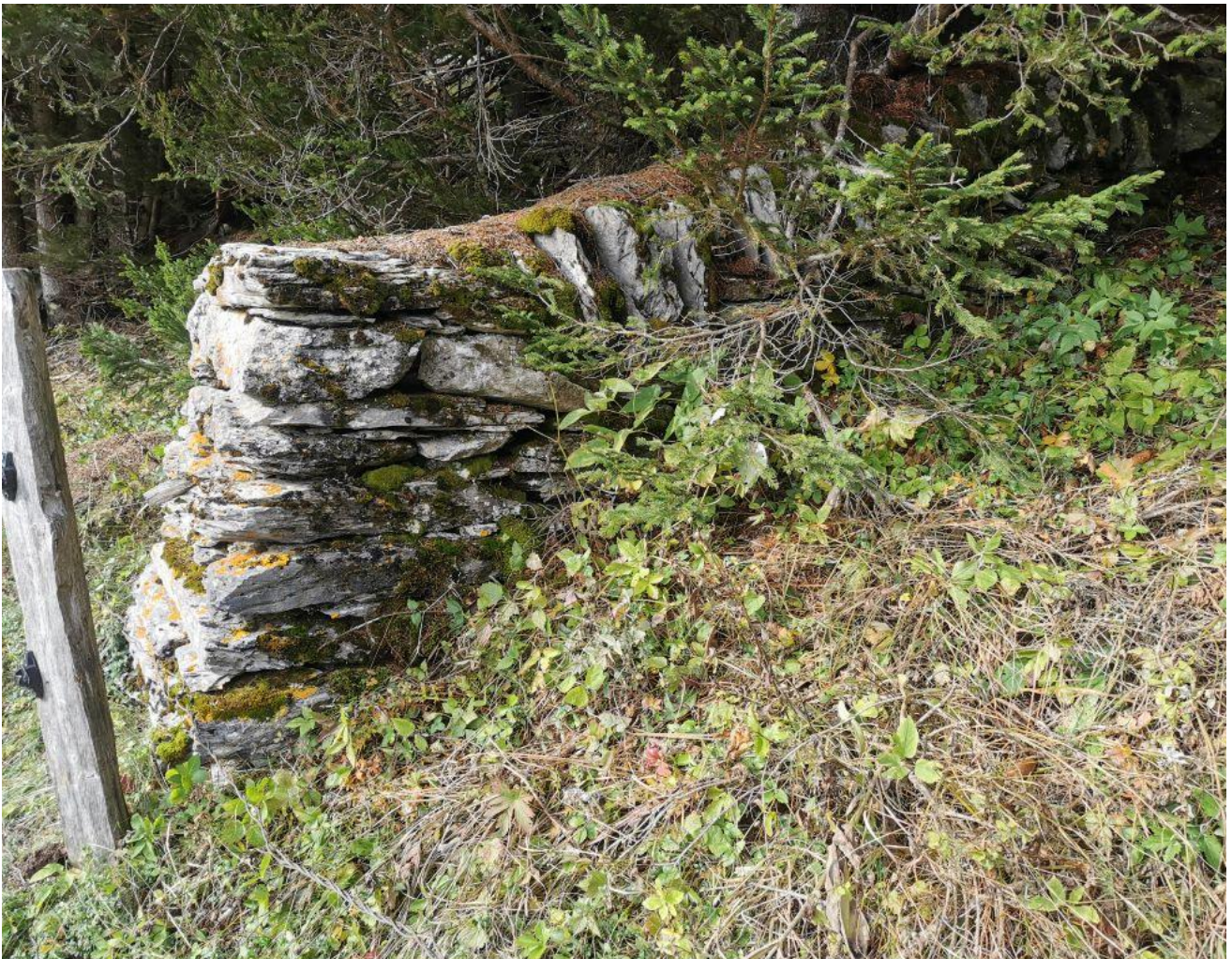
Abbildung 2: Unteres Ende der Grenzmauer Valladorta-Sässhopf
