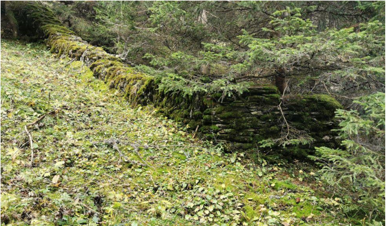
Abbildung 4: Unteres Ende des oberen Abschnittes der Grenzmauer auf ca. 1'631 m Höhe
