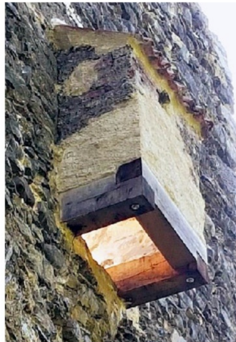
Dieser Abort-Erker konnte dergestalt rekonstruiert, resp. wieder ergänzt werden, dass die Ablesbarkeit, was Bestand war und was neu hinzugefügt wurde, gewährleistet wird und zugleich die originalen Fragmente geschützt und erhalten werden.
