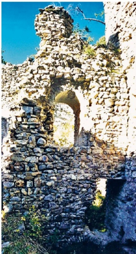
Ansicht eines Teilbereichs der Trennmauer zwischen dem Süd- und Nordannex im Bestand. Der freistehende und sich nach unten verjüngende «Mauerzahn» stellte wie der fehlende Türsturz ein zu priorisierender Mauerbereich dar.
