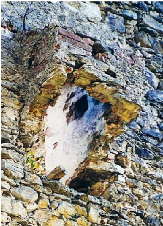
Auf der Nordseite des Nordannex waren noch Mauerfragmente eines typischen Abort-Erkers mit originalem Innenputz vorhanden.
