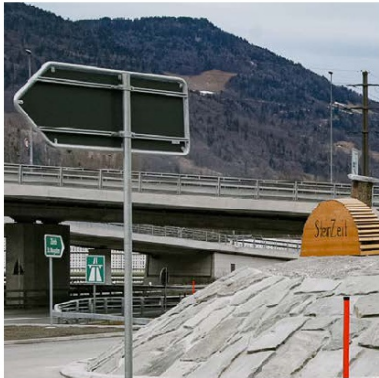
Der Kreisel Rappagugg beim A13-Anschluss Zizers wurde von der Firma SteinZeit gestaltet und die Trockenmauer ohne Mörtel und Beton, Stein für Stein, aufgeschichtet. Ein gepflasterter Weg führt direkt zum kreisrunden Loch in der Trockenmauer und soll den Eintritt nach Zizers symbolisieren.
