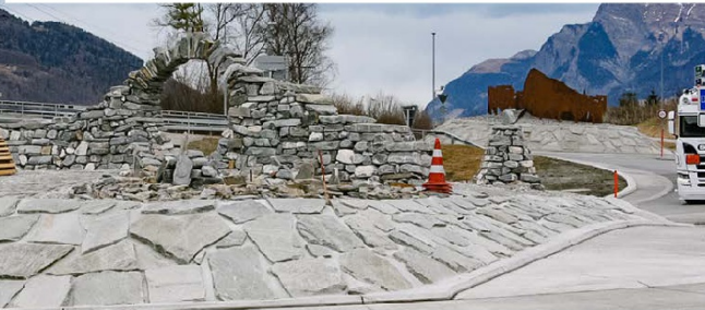
Der Kreisel Rappagugg beim A13-Anschluss Zizers wurde von der Firma SteinZeit gestaltet und die Trockenmauer ohne Mörtel und Beton, Stein für Stein, aufgeschichtet. Ein gepflasterter Weg führt direkt zum kreisrunden Loch in der Trockenmauer und soll den Eintritt nach Zizers symbolisieren.
