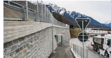
Die 97 Meter lange Stützmauer mit einer variablen Höhe von sieben Metern wurde im für den Kanton Graubünden typischen Natursteinformat erstellt.
