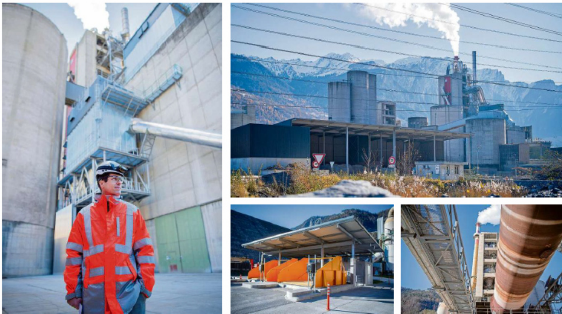
Millioneninvestitionen in die Zukunft: Fabio Widler, designierter Leiter des Zementwerks Untervaz, zeigt den Gas-Bypass (links im Hintergrund), das Projekt «Road Runner» (Mitte unten), mit dem Strassenabfälle in den Kreislauf zurückgeführt werden können, sowie den gigantischen Dreihohlen (rechts), in welchem Temperaturen von 1500 Grad erreicht werden.
