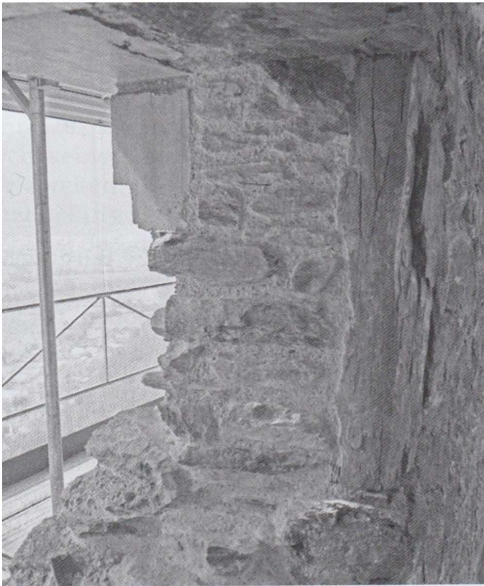
Alt und neu vermischen sich bei der Sanierung.
