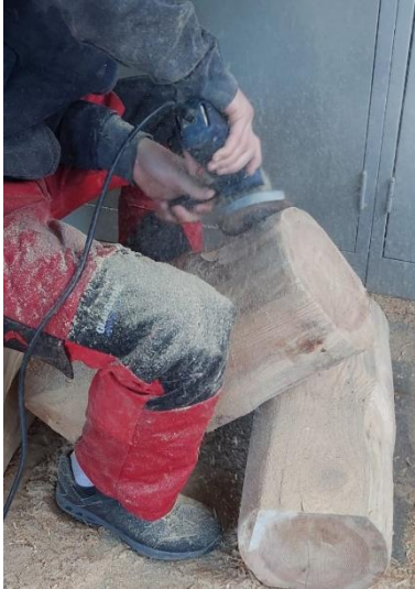
Abbildung 8 Sockel schleifen
