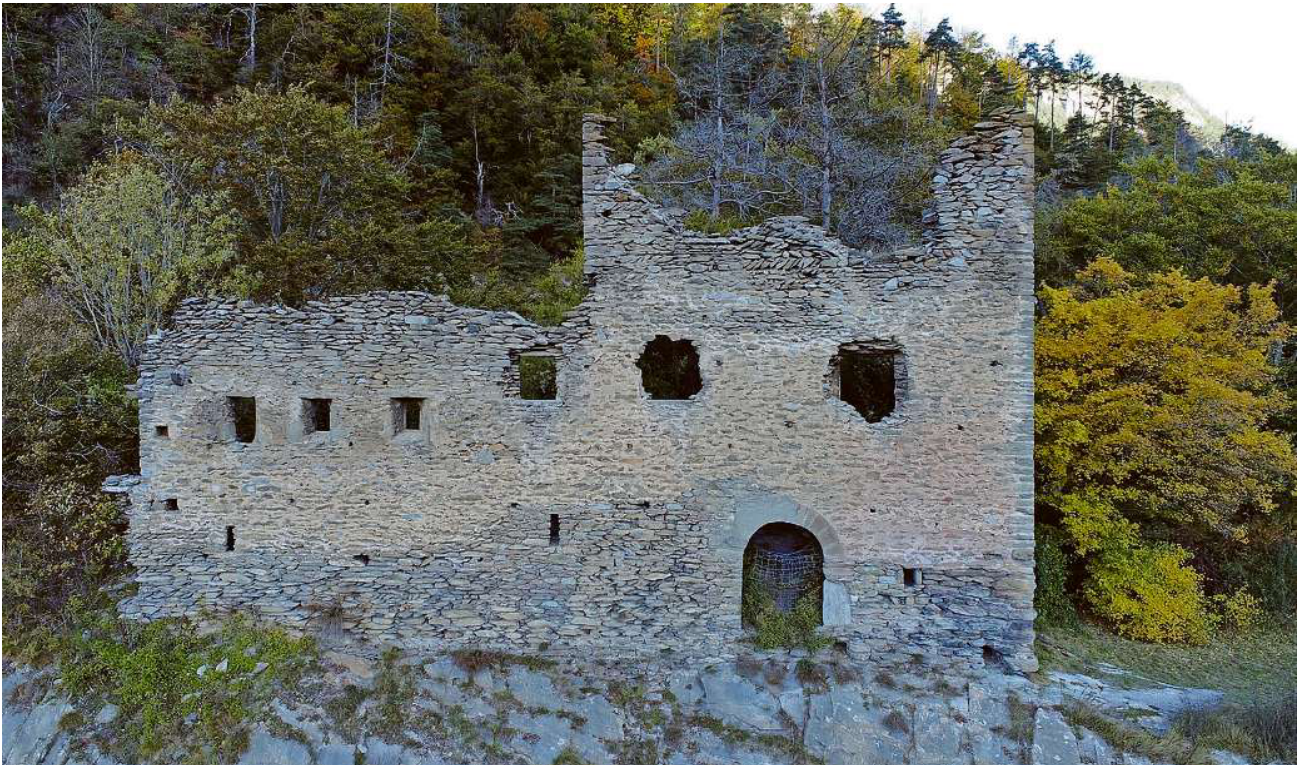
Verwittert: So präsentierte sich die Katzenburg vor Beginn der Instandsetzungsarbeiten.
