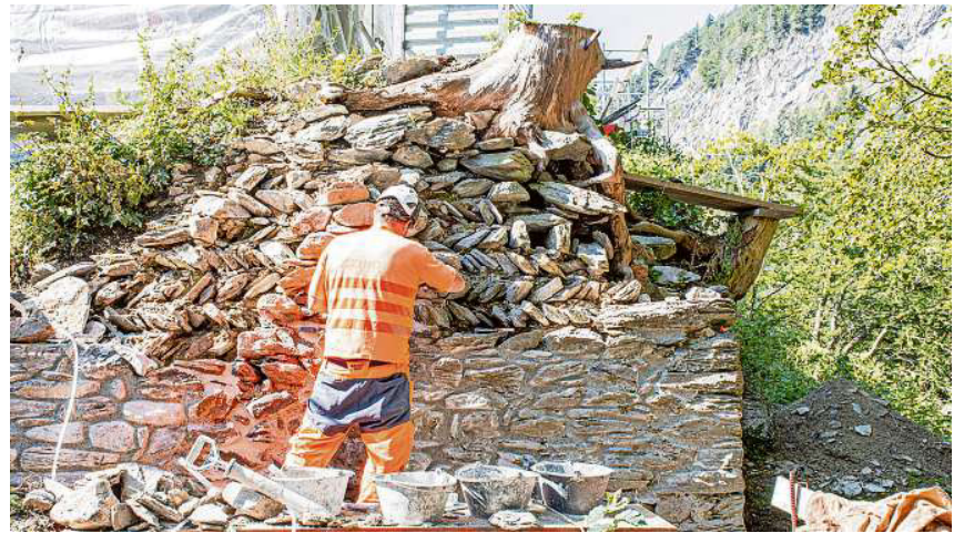
Kunstvoll: Erfahrene Maurer sind dabei, die Mauern mit einem speziellen Mörtel zu sichern. Auf dem Bild ist ebenfalls zu sehen, wie stark Wurzeln ins Gemäuer eindringen können.
